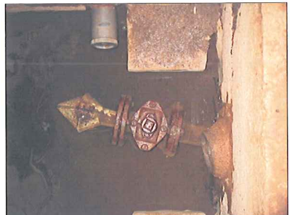
Photo 5 : Captage – vue intérieure, crépine et trop-plein
