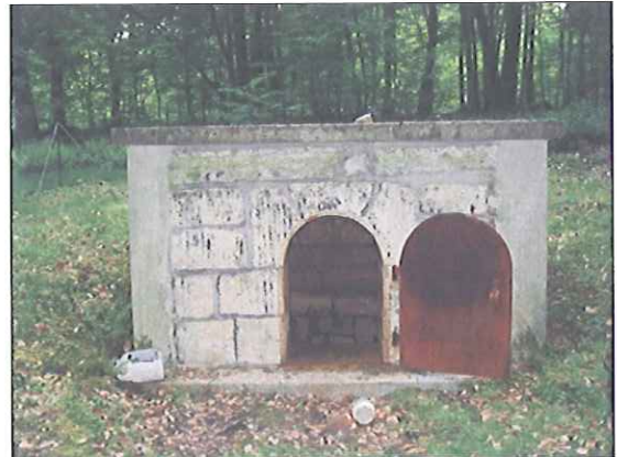
Photo 3 : Captage de la source de Brot
