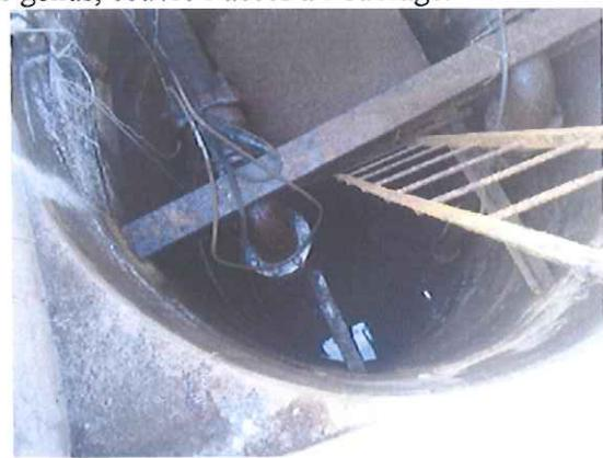
Le trop-plein prévu sous la margelle n'a pas été réalisé. Il était destiné à évacuer les eaux jaillissantes du puits vers le ruisseau des Forges par une dépression creusée dans la parcelle.
