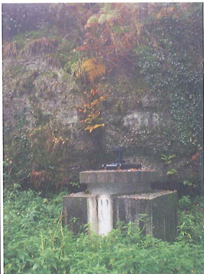
Captage de la Fontaine qui Saute
