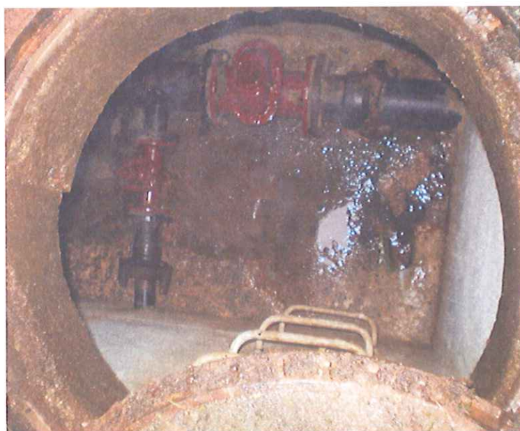
Vue intérieure de la chambre des vannes
