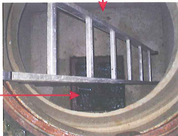
Partie inférieure de l'ouvrage (hauteur : 1,50 m)
