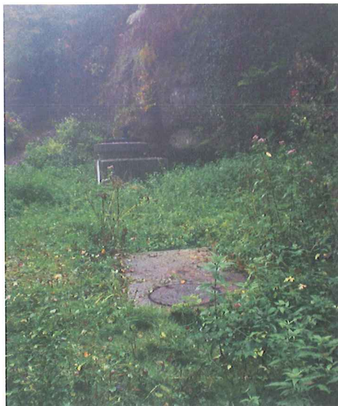
Captage et chambre des vannes
