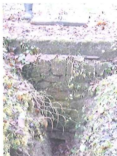
**La protection naturelle :** Les grès rhétiens qui sont exploités par le captage de la source de l'Epi sont affleurants sur une large surface. En conséquence, l'aquifère ne bénéficie d'aucune protection naturelle autre que la filtration au travers la zone non saturée. Cette situation est particulièrement bénéfique lorsque le substratum se trouve, comme ici, constitué de grès peu consolidés susceptibles d'améliorer la qualité.
