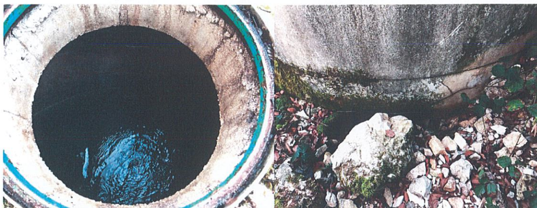
Figure 5 : Vue de l'intérieur du captage et des ouvertures de trop plein
