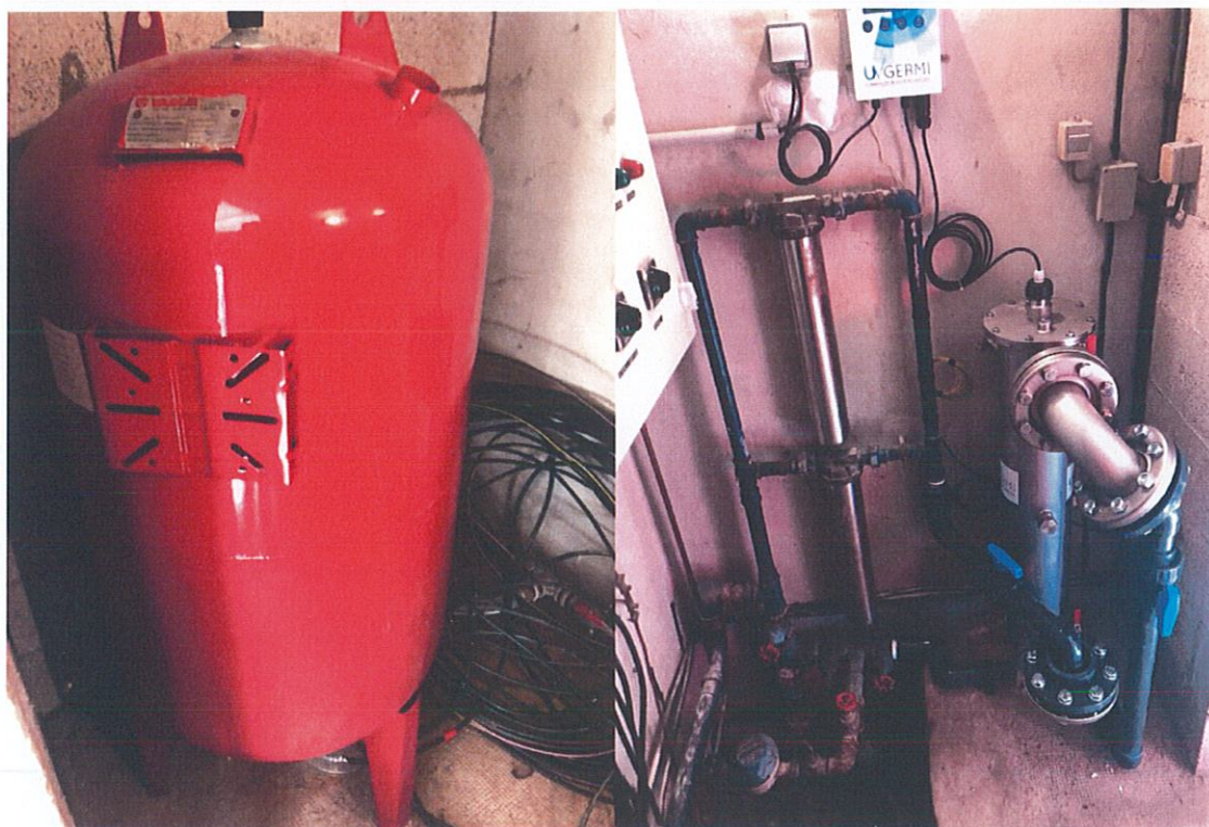
Figure 6 : Vue du ballon réservoir et du dispositif de traitement
