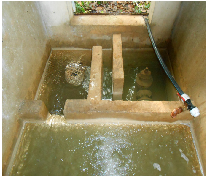
photo n°2: sortie de l'eau, trop-plein,crépine et conduite
