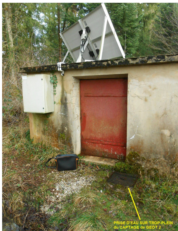
photo n°11: prise d'eau sur trop-plein du captage Geot 2
