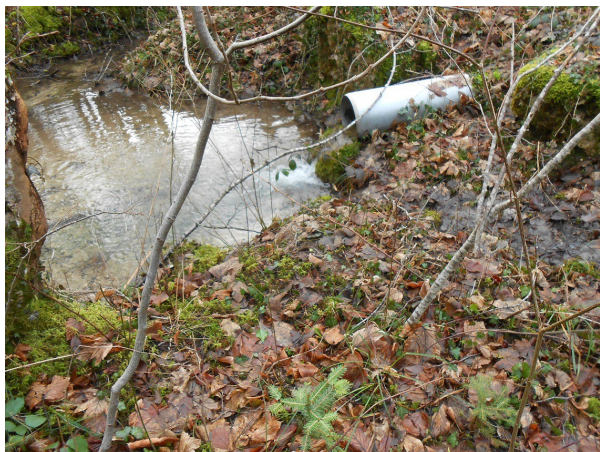
photo n°7:sortie du trop-plein du captage de La Léchette
