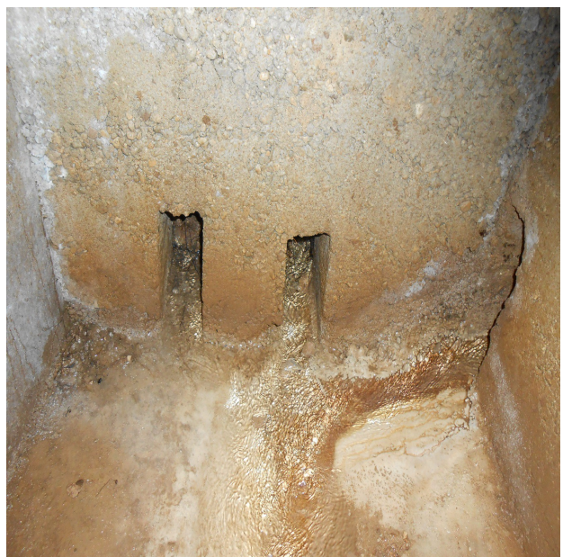
photo n°3:galerie NW vue des barbacanes latérales photo n°4:galerie NW vue des barbacanes de fond
