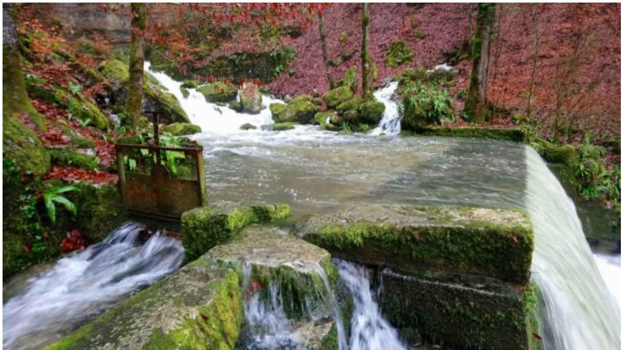
Figure 5 : Vue de l'alimentation du bassin par la vanne guillotine
