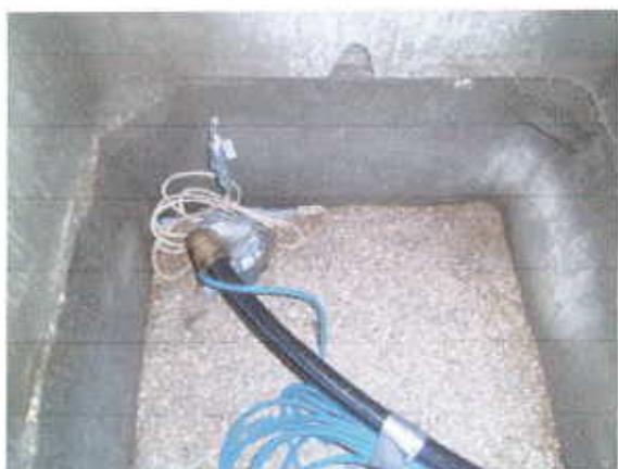
Photo 2 – vue intérieure du captage avec la tête du forage
