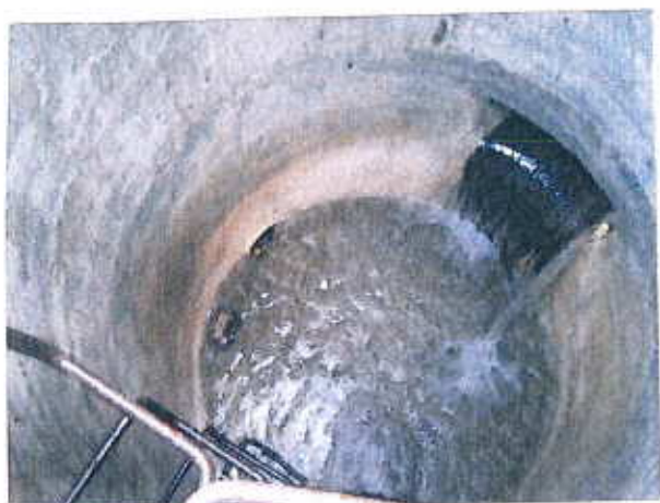
Captage du Cuvruve Queues de renard dans un drain
