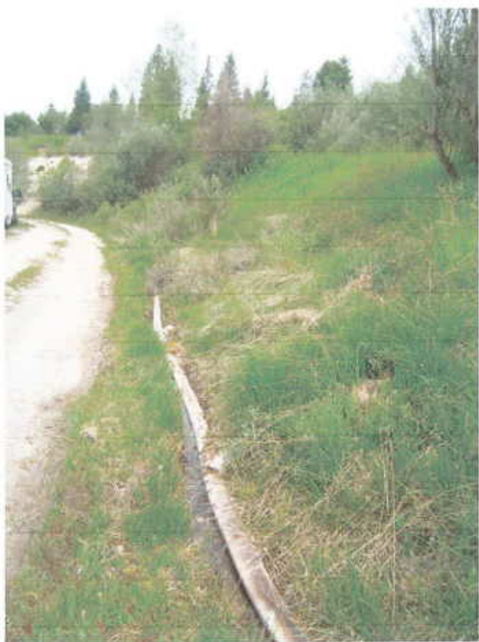
Photo 8- Conduite de liaison des regards de sources 1, 2 et 3 Au pied du talus et dans sa tranchée
