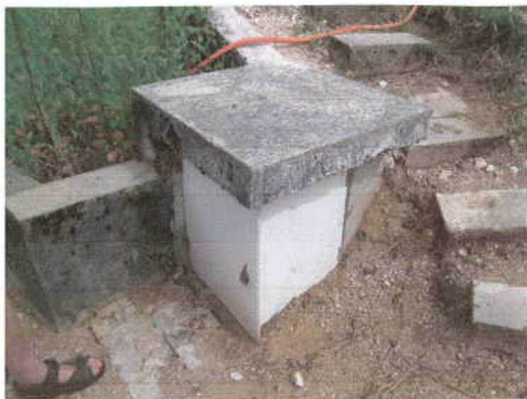
Photo 3- Le regard principal aval de collecte des eaux brutes des sources captées à la station de pompage
