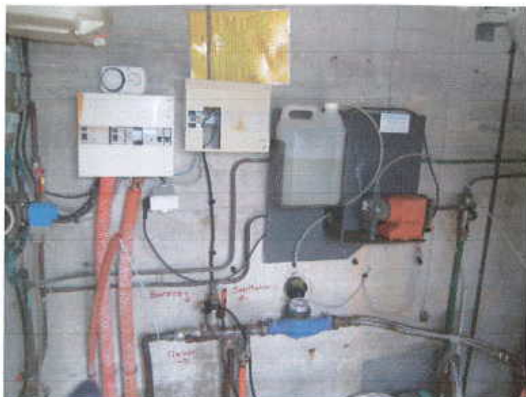
Photo 2- Station de pompage avec le réservoir d'arrivée des eaux
