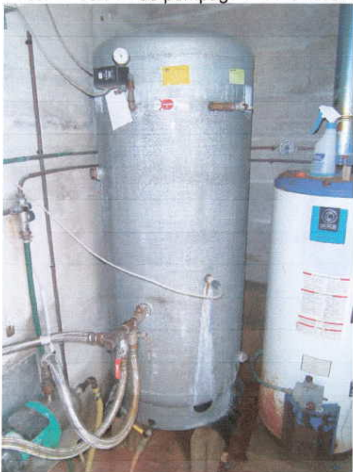
Photo 2- Station de pompage avec le réservoir d'arrivée des eaux
