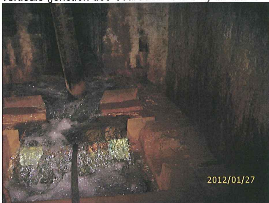
Bac de réception de la source n° 4 (en fond) et de la conduite acier verticale (jonction des Sources n°5 et n°6) du site C
