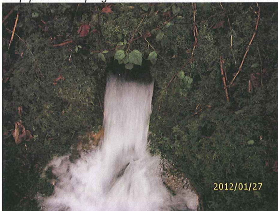
Trop plein du captage des sources n°1 et n°2 du site A
