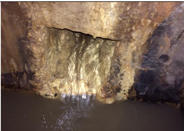
Le drain d'alimentation de l'ouvrage
