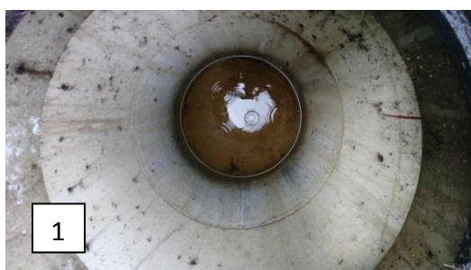
Figure 9 : Vues des buses béton à l'amont immédiat du captage.
