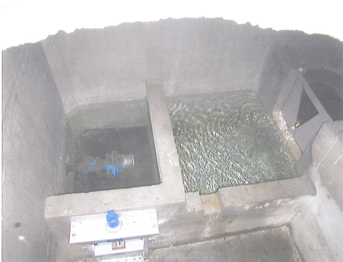
Arrivée du drain ouest dans le regard intermédiaire
