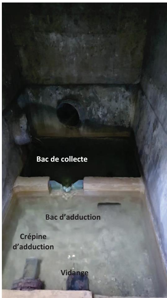
Figure 7 : Vues intérieures de l'ouvrage de collecte
