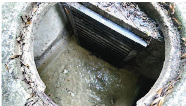
Figure 8 : Vues de la sortie de trop-plein de l'ouvrage de collecte
