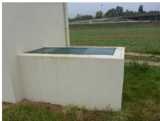
P4 - Chambre de captage le long du local technique
