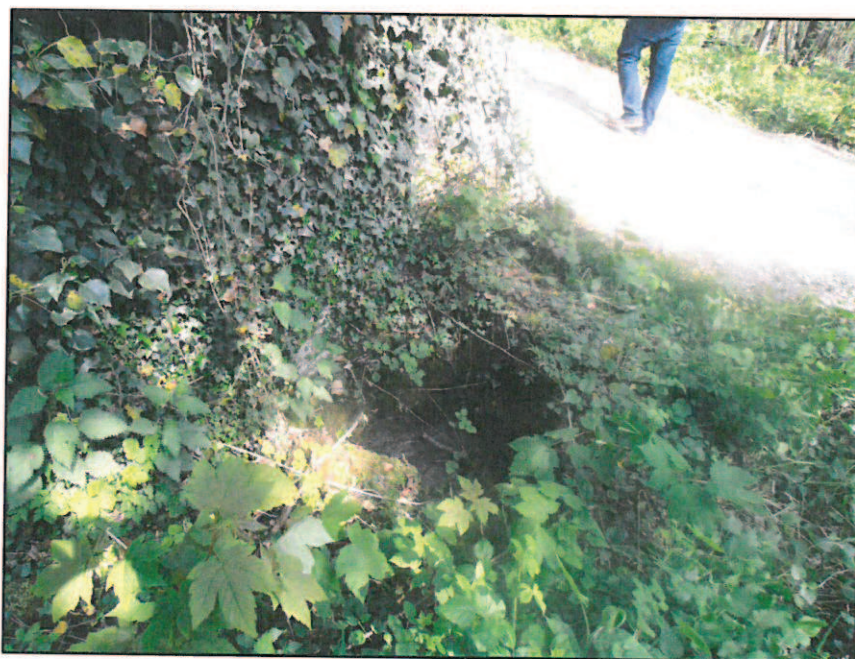
Figure 7 : petit ruisseau au pied du captage dans lequel se déverse le trop-plein en cas de mise en charge avant de traverser la route d'accès à la ferme du Giboux
