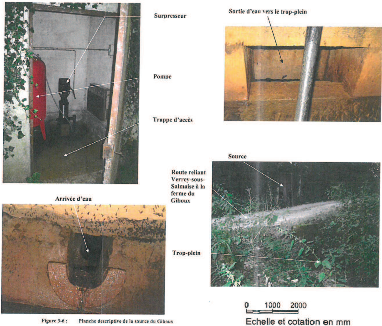
Figure 8 : local du captage de la « source du Giboux » et chambre souterraine (source : SAFEGE)
