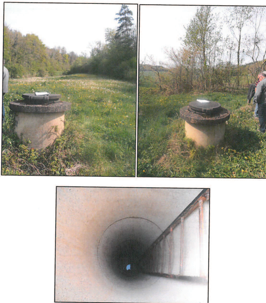
Figure 3 : la cheminée d'accès au captage de la « source de la Dame »
