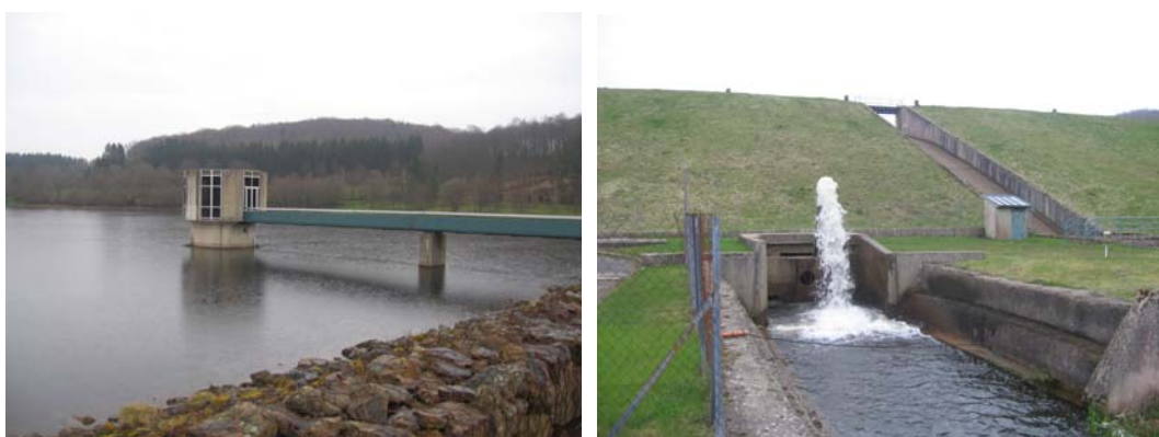
Clichés 5 et 6 – La tour de prise d'eau et la restitution du débit réservé
