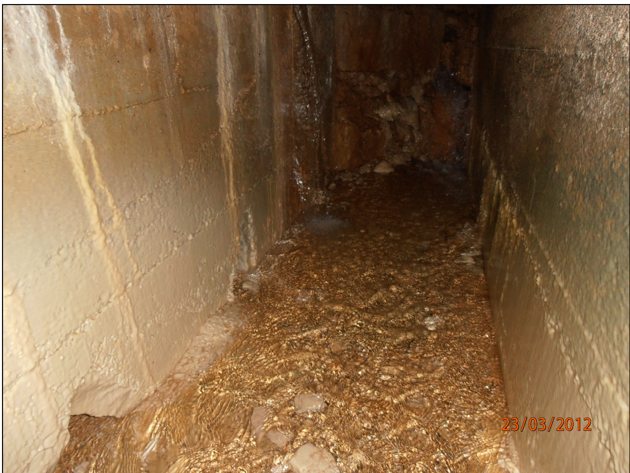
Clichés 12 à 14 : les arrivées d'eau au droit des barbacanes et au droit de la paroi calcaire en fond de galerie
