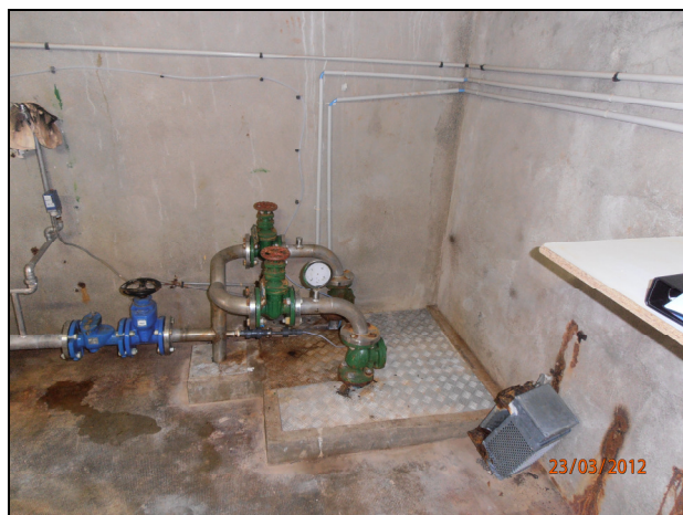
Clichés 19 et 20 : local de pompage et de traitement situé au dessus de la bête de reprise
