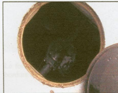
Le pétitionnaire a fait réaliser un forage sur le site de DIJON CEREALES à PONT. L'ouvrage a été exécuté par l'entreprise PRECIFORAGES du 18/11 au 04/12/02. Le sondage profond de 40 m a été équipé jusqu'à - 16 m de profondeur pour exploiter l'aquifère alluvionnaire traversé entre - 4 et - 12 m.
