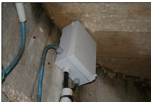
Clichés 5 et 6 : tampon non jointif et traces d'humidité au plafond de la tête de puits
