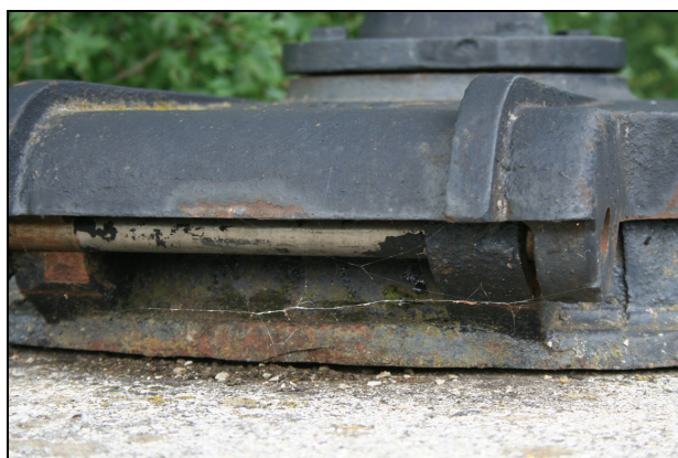
Clichés 5 et 6 : tampon non jointif et traces d'humidité au plafond de la tête de puits
