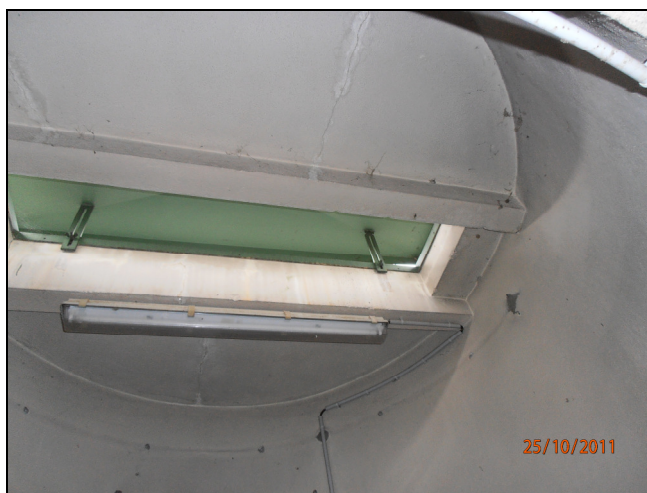
Cliché 3 : Trappe d'accès et de ventilation
