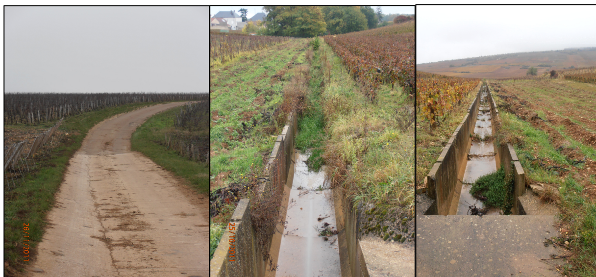
Clichés 23 à 25 : chemin imperméabilisé et caniveaux étanches
