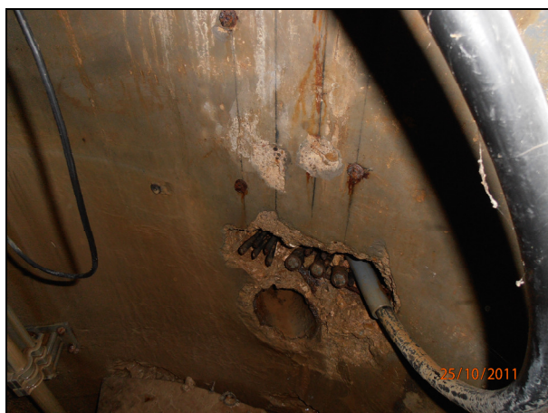
Clichés 6 à 8 : anciens réseaux divers arrivant au puits
