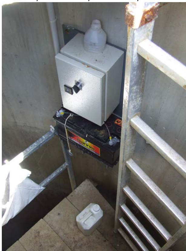
Batterie au plomb dans la tête de puits, au dessus du plan d'eau
