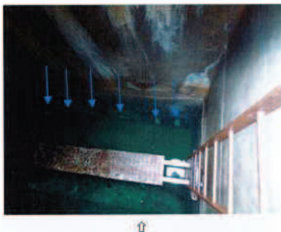
L'eau parvient dans la première chambre par des drains (↓).
