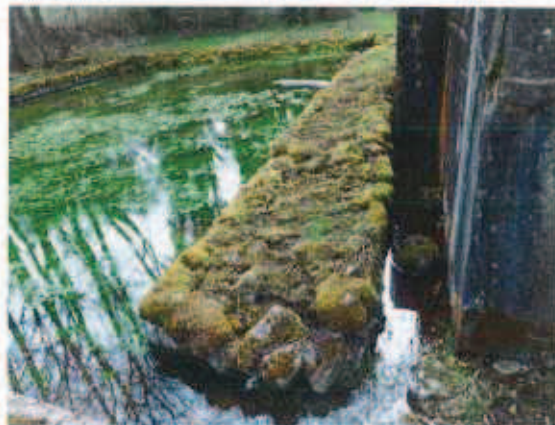
Fissures avec développement de mousses
