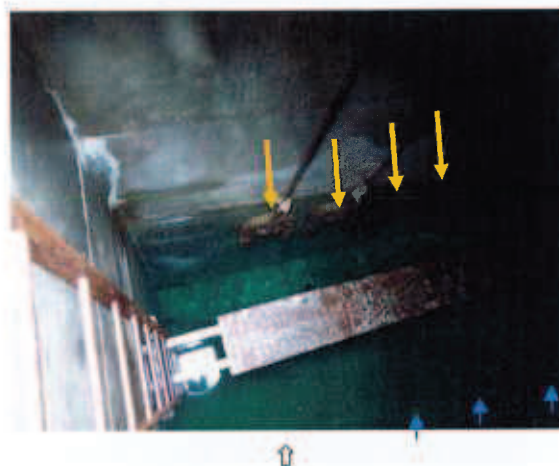
L'eau parvient à la seconde chambre par des ouvertures munies de vannes (↓).
