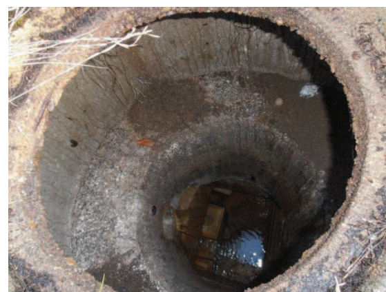
Non étanchéité des buses en ciment
