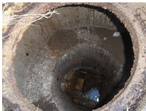
Non étanchéité des buses en ciment
