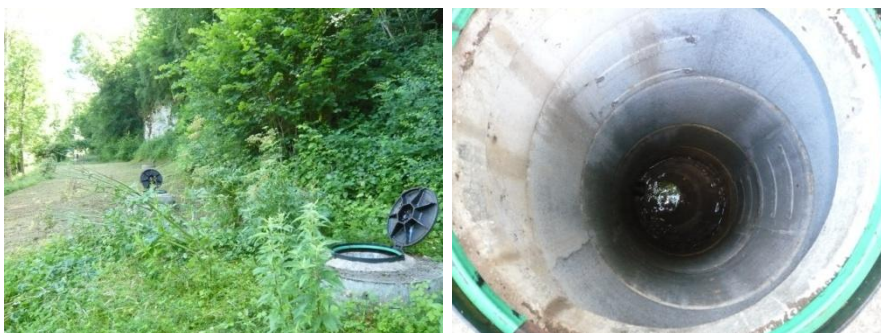
regards d'extrémité des drains
