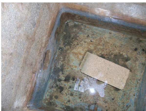
Clichés 13 & 14 : regard et déversoir permettant la mesure du débit
