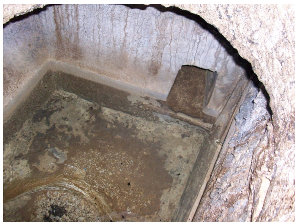
Clichés 5 & 6: vues de l'intérieur du regard latéral et présence d'une "queue de renard"
