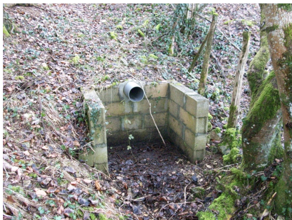
Clichés 13 & 14 : regard et déversoir permettant la mesure du débit
