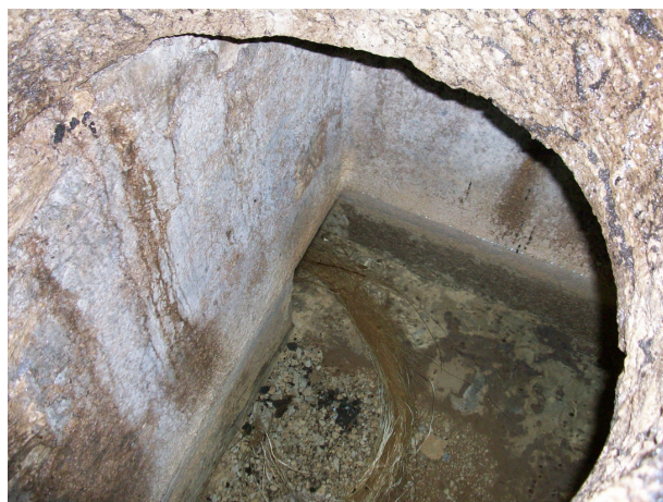
Clichés 5 & 6: vues de l'intérieur du regard latéral et présence d'une "queue de renard"
