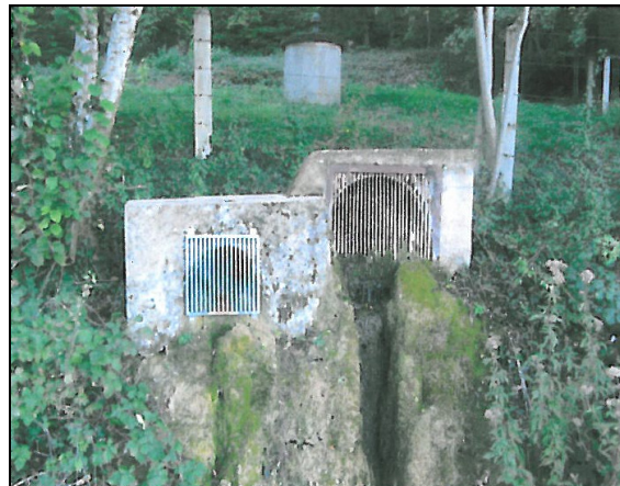
Clichés 9 et 10 : vue des trop-pleins à l'intérieur du regard Nord et à l'extérieur de la zone de captage
