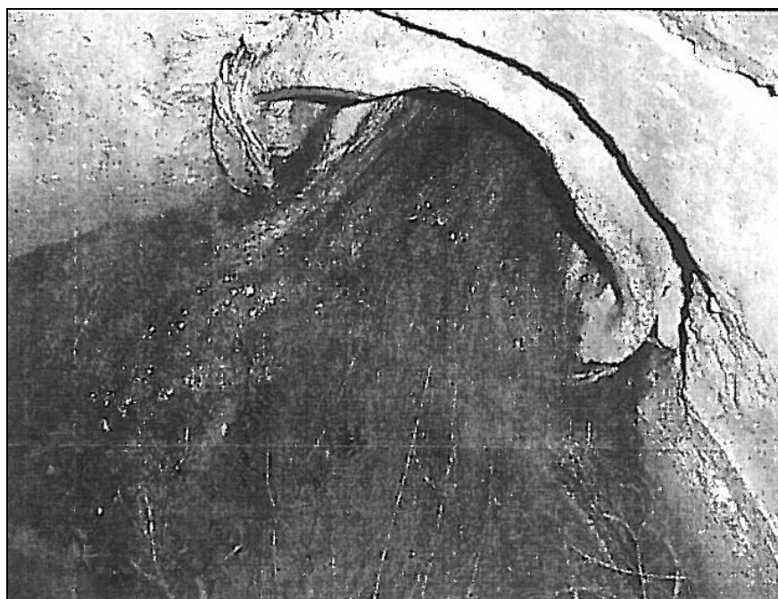
Cliché 12 : arrivée du drain Nord dans la chambre de visite n°2
