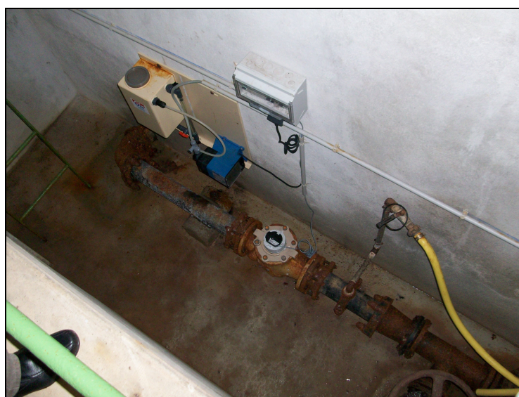
Cliché 15 : système de chloration
