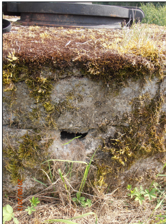
Clichés 5 et 6 : présence d'ajournements à la base de la dalle de couverture du puits P1
