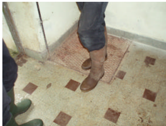
Accès à la bâche sous une plaque métallique (accès non protégé des éventuelles souillures apportés par les personnes accédant au local)
