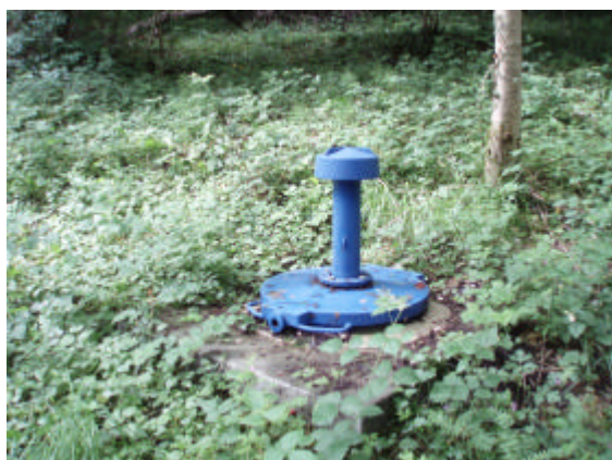
Tampon type Foug mis en place en 2003-2004 pour l'accès à la galerie, regard situé sur la parcelle 647.
