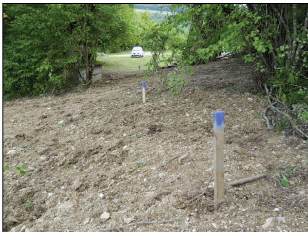
Clichés 13 et 14 : repérage des drains après remblaiement
