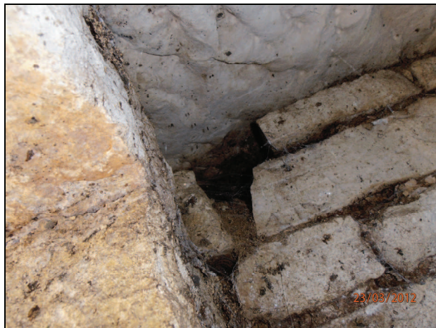
Clichés 4 et 5 : l'intérieur du captage en pierres sèches
