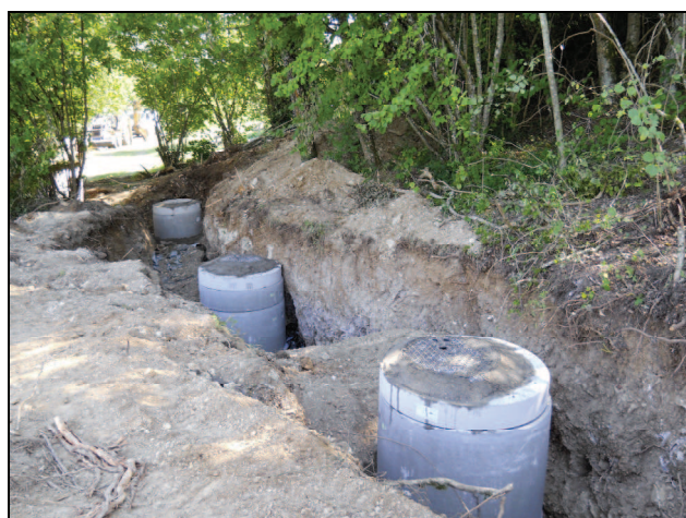
Clichés 11 et 12 : les regards n°1 à n°3 lors de la reprise des drains
