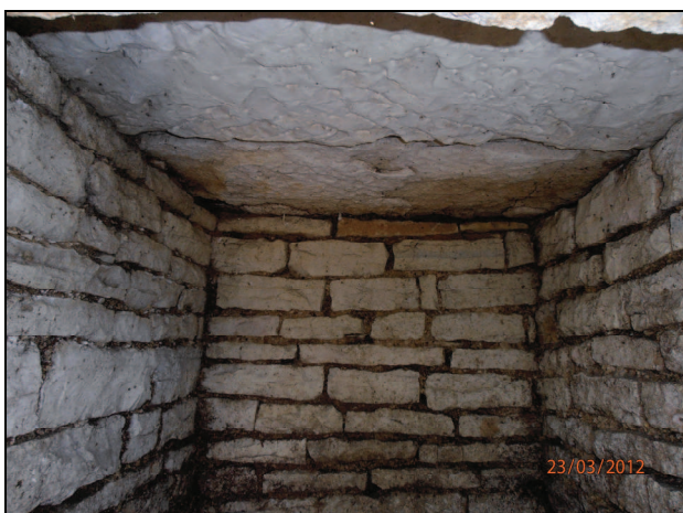
Clichés 4 et 5 : l'intérieur du captage en pierres sèches
