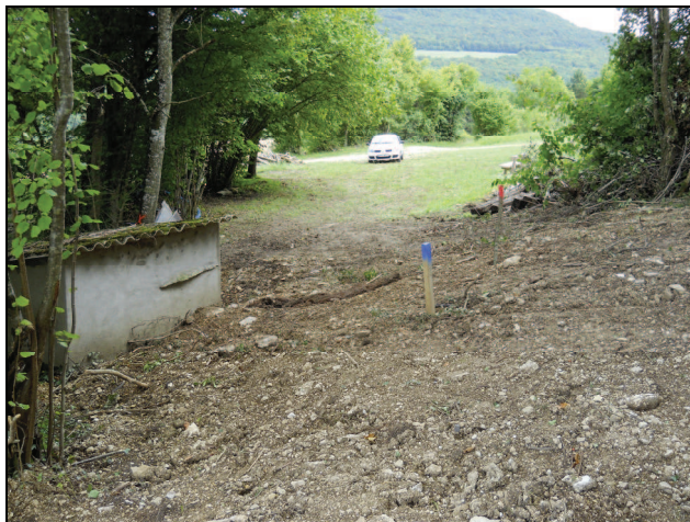
Clichés 13 et 14 : repérage des drains après remblaiement
