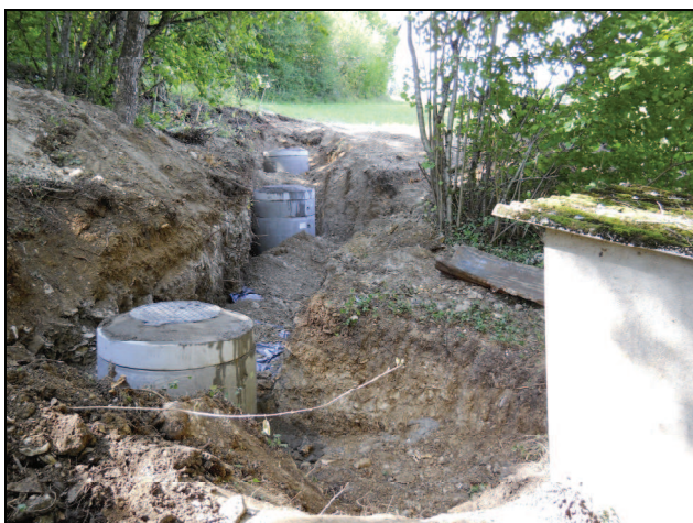
Clichés 11 et 12 : les regards n°1 à n°3 lors de la reprise des drains
