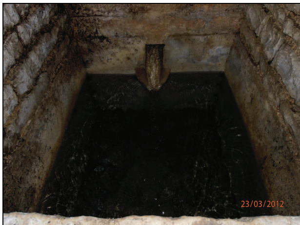
Clichés 7 et 8 : arrivée des eaux captées et trop plein
