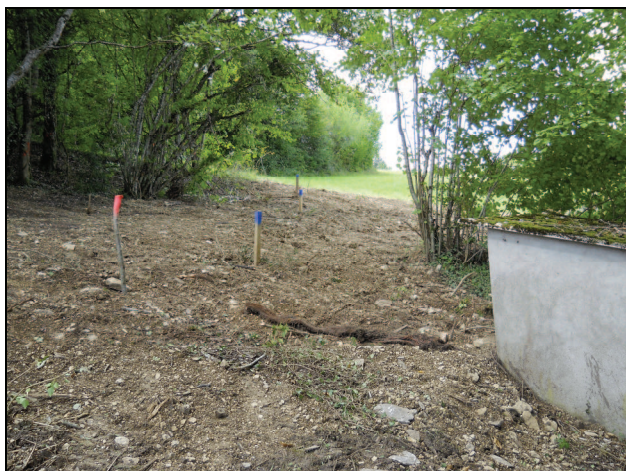
Clichés 15 et 16 : repérage des drains après remblaiement
